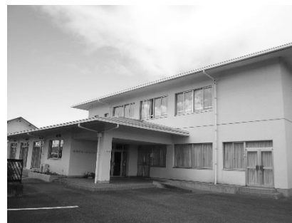
岐南町北町民センター（写真 2）
